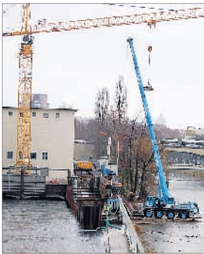
LETTENWEHR Fischtreppe ist im Bau. MARTIN REICHLIN
